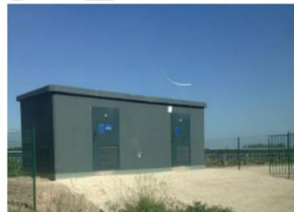
Poste de livraison
