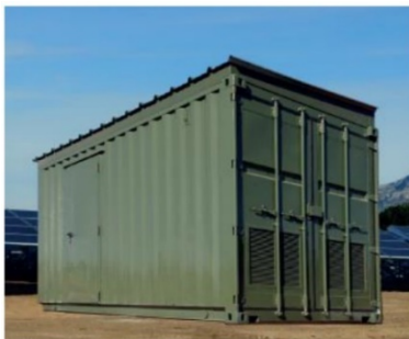
Local de maintenance
