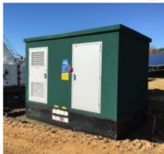
Poste de transformation
