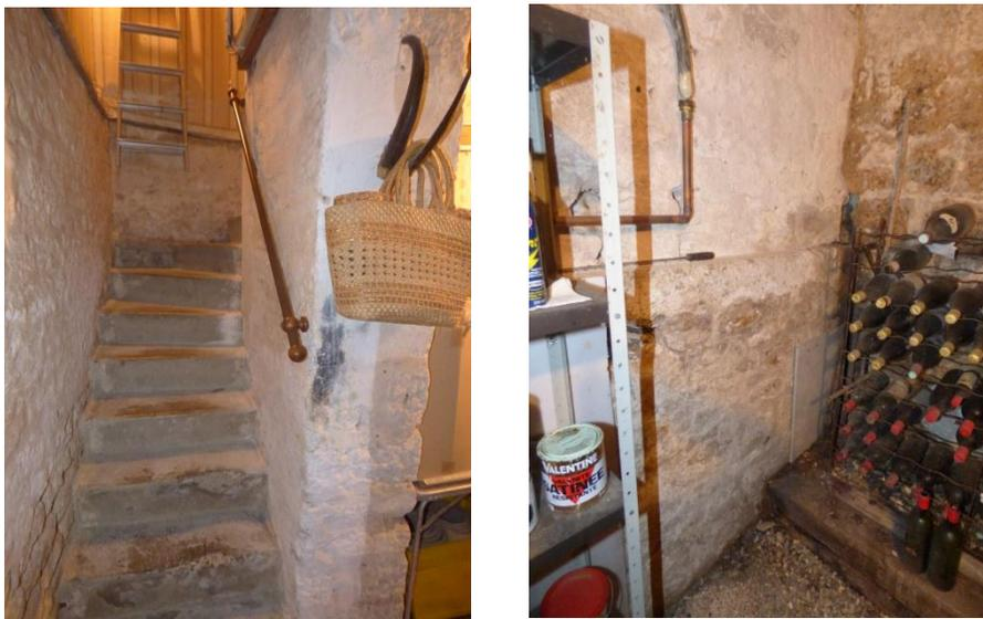
L'épaisseur plus importante du mur au niveau inférieur au sol et l'appareil différent font penser à une période antérieure à la construction de la maison.
