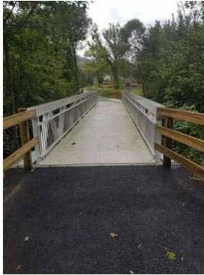
IC de la Bruche – Structure aluminium – revêtement polyuréthane « résine »
